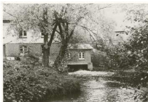
Neue Wassermühle mit Weislide 1930-1940
