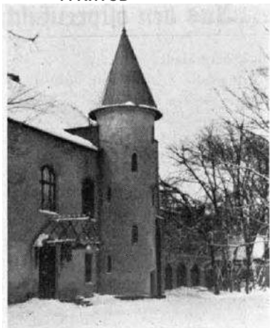
Rundturm am Eingang zum Herrenhaus
