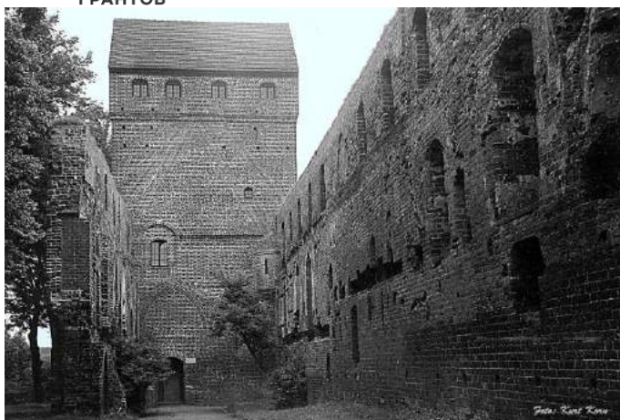
Burg Balga - Vorburg im Jahr 1939 - zu erkennen sind 2 Geschosse (im Turm 3) und Spuren von Kaminen. Zwischen dem 2. und 3. Geschoss des Turmes springt die Treppe im Innern in ein Türmchen vor. Diese Abweichung musste aus bautechnischen Gründen bei der Sanierung in Kauf genommen werden.
