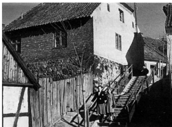
Heiligenbeil, Treppenverbindung von der Töpferstraße zur Stallstraße Archi
