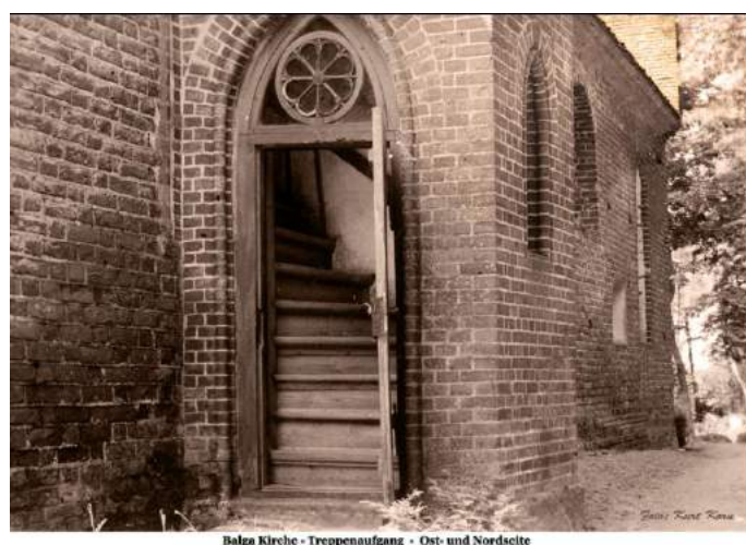
Balga Kirche - Treppenaufgang - Ost- und Nordseite
